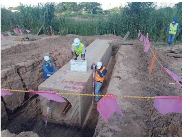
写真-5 道路横断排水路設置状況
