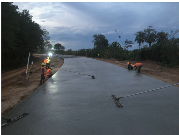
写真-9 自動制御によるカーブ部の施工
