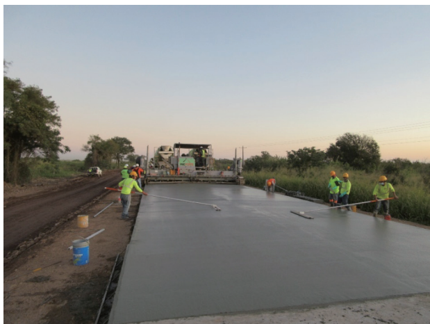
写真-6 南工区全景(既設道路との擦り付けによる拡張部分)
