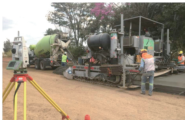
写真-7 3D測量システムによる舗装機械の制御システム
