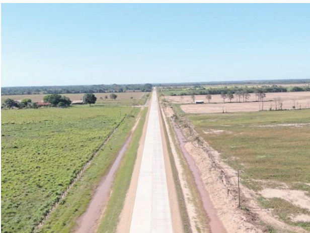
写真-4 完成した道路と道路脇水路
